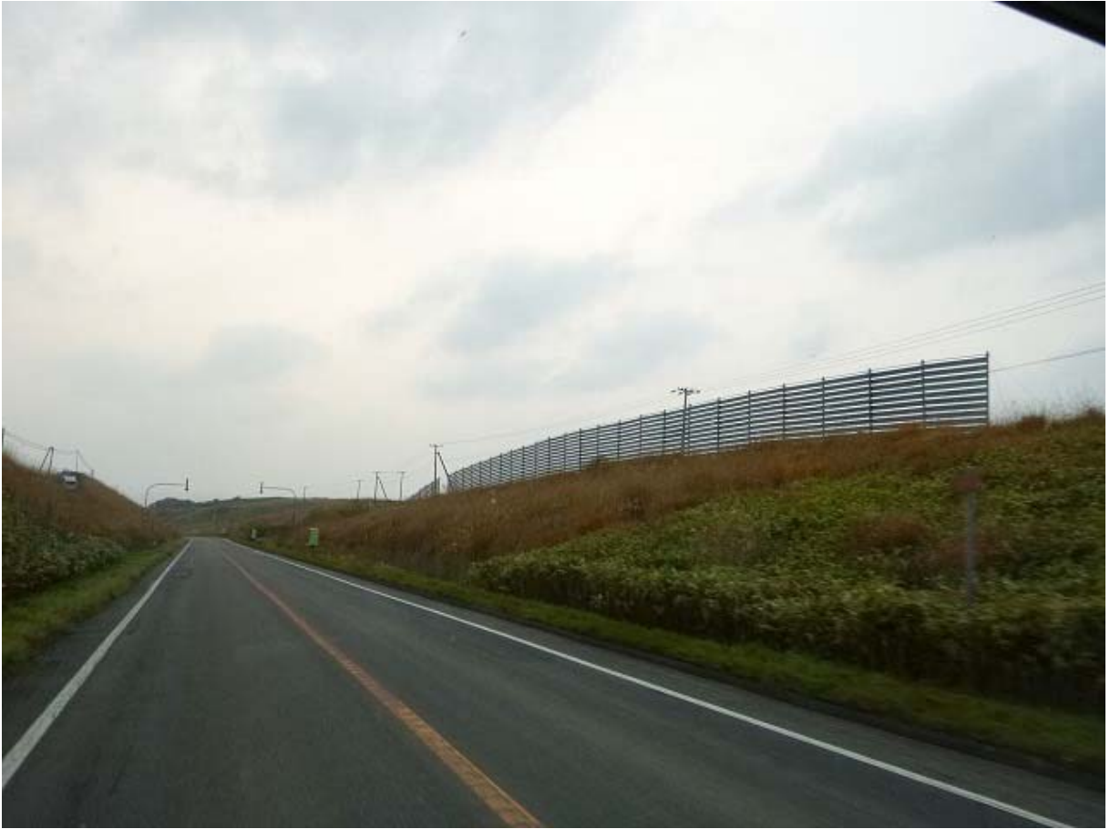
写真 8.11 防雪切土（3）、斜面の頂部に吹き止め柵が設置されている
