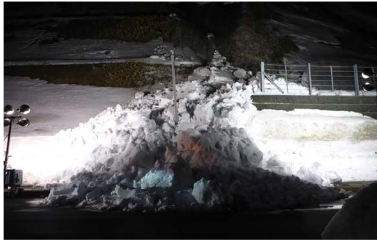
写真 8.10 令和4年3月の雪崩状況（R232号力昼）
