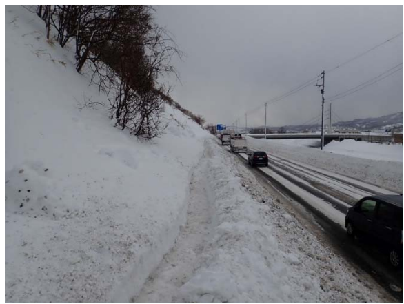
写真 8.2 法尻部のポケット作成の状況（R232）
