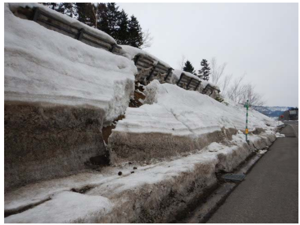
写真 8.1 最下段の雪崩の状況（深川留萌自動車道）
