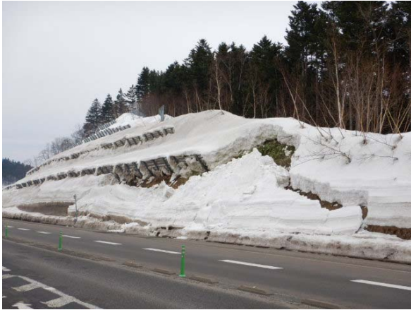
写真 8.1 最下段の雪崩の状況（深川留萌自動車道）
