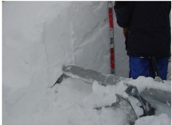
写真 6.5 雪崩予防柵の周りの積雪状況 (R40号 豊富 BP)
