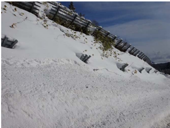
写真 6.10 最下段のグラライド防止杭
