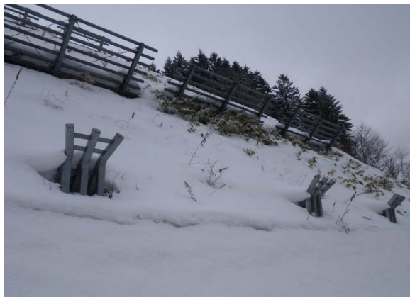
写真 6.6 柵最下段の下部に設置されたグライド防止杭（R236号 清陵）
