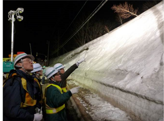
写真 6.3 雪崩発生現場の法尻の除雪状況 (R230号 中山峠)
