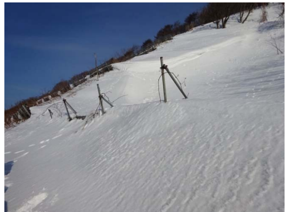
写真 6.11 斜面積雪のグラライド防止を目的とした単管仮設杭
