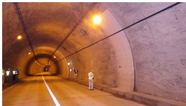
写真 5.2 坑口から 240m 付近の面導水工
