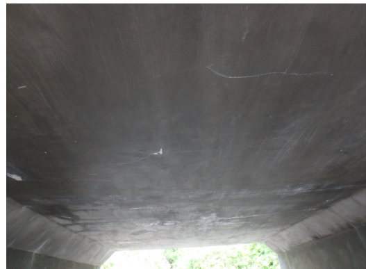
頂版：部分修復（犠牲陽極）、含浸材 未補修部でひび割れと遊離石灰
