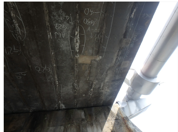
主桁補修状況（断面修復）
