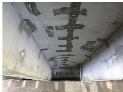
桁裏補修状況
