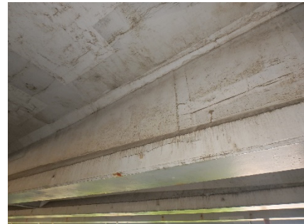
主桁の状況（主桁間）
