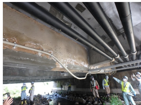
桁裏補修状況、通電設備
