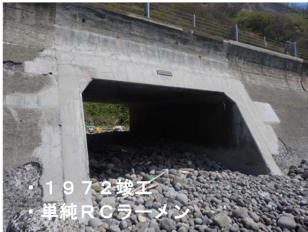
頂版：部分修復（犠牲陽極）、含浸材 未補修部でひび割れと遊離石灰
