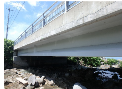
主桁の状況（上流端）
