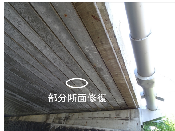
主桁補修状況（断面修復、含浸材）
