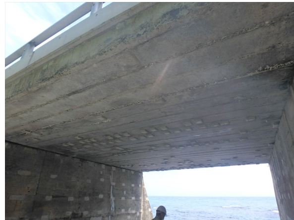
主桁補修状況（陸側）
