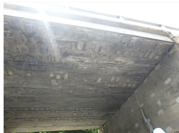
主桁補修状況（海側）
