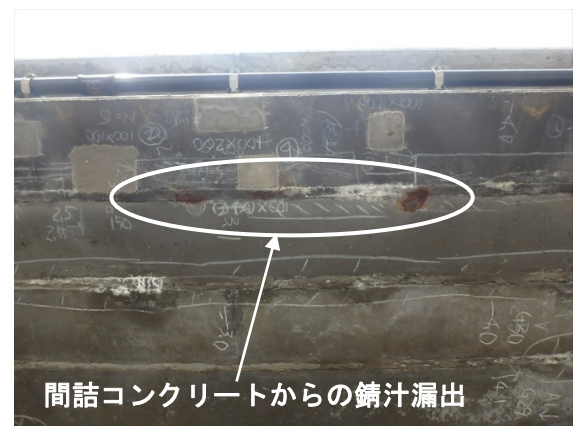
主桁補修状況（断面修復）
