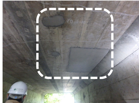
頂版の補修状況（部分修復）
