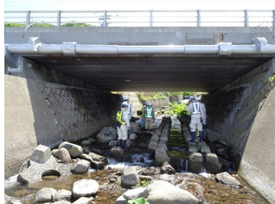
主桁補修状況と再劣化の状況確認
