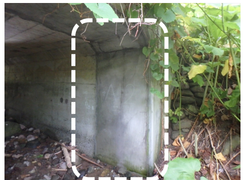
側壁小口部の補修状況（全断面修
