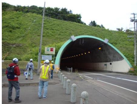
写真 6.7 豊浜トンネル視察状況
