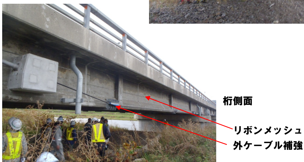
写真 5.5 彦部橋 電気防食工法（リボンメッシュ）
