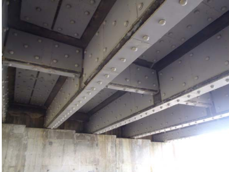
写真 5.3 雄冬橋 電気防食工法（防食パネル）
