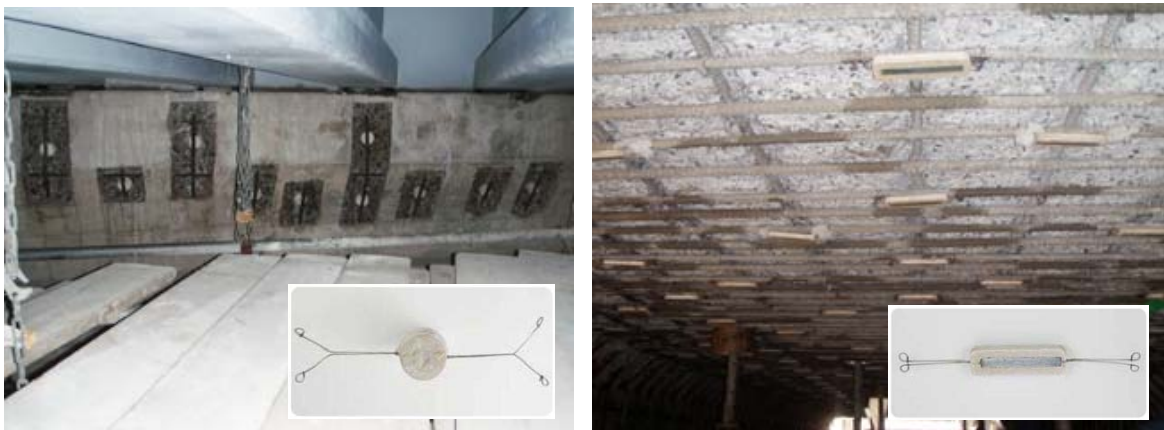
図 5.13 ガルバーシールド工法の適用事例
