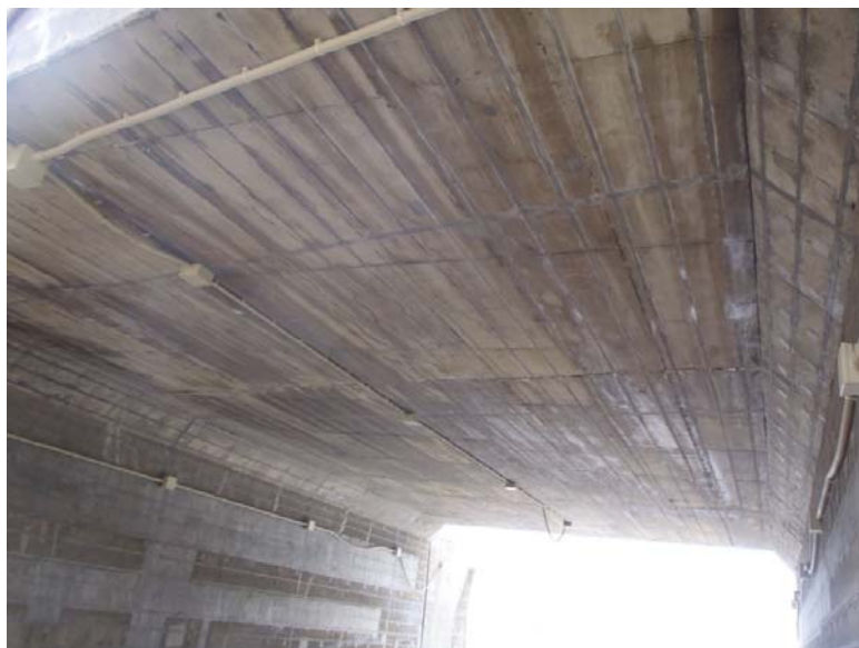
写真 5.4 湯泊橋 電気防食工法（リボンメッシュ）
