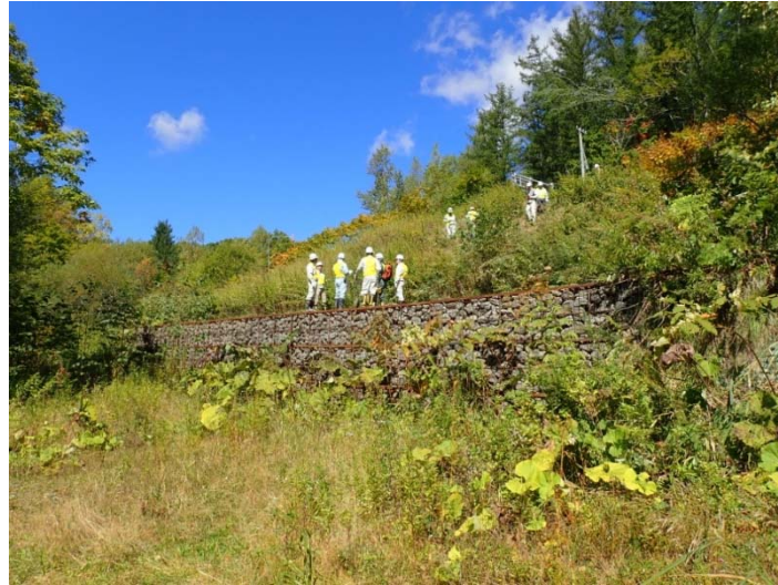
写真 4.16 鋼製枠擁壁工（平成 29 年 9 月 22 日撮影）
