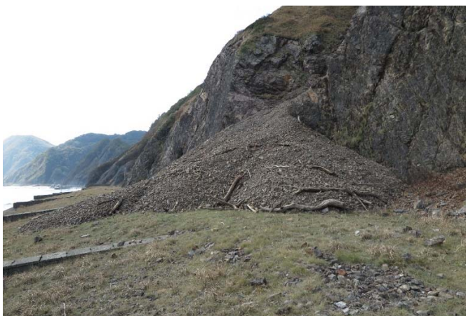
写真 3.4 覆道上の土石流堆積物と UAV 調査状況
