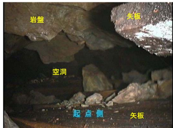
写真 6.1 背面空洞の例
