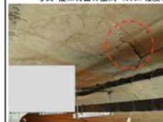
写真-突発性崩壊による覆工コンクリートの損傷 （空洞高さ約80cmと大きく、覆工厚さが10～15cmで極端に薄かった）
