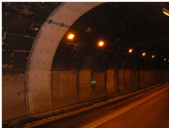
写真 6.4 漏水対策工の例
