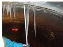
写真-横断目地からの水柱（一晩で50cm以上成長する時もある）
