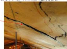
写真-突発性崩壊による覆工コンクリートの損傷 （空洞高さ約80cmと大きく、覆工厚さが10～15cmで極端に薄かった）
