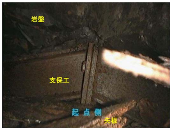
写真 6.1 背面空洞の例
