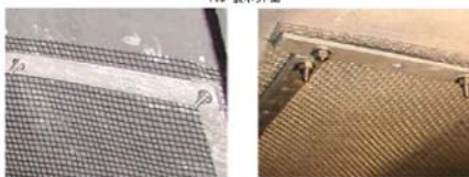
ジオグリッド製ネット工
