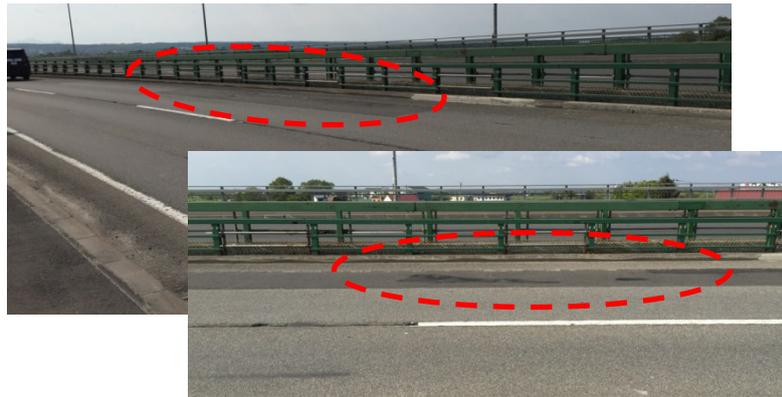
写真 5.6 上り線の舗装補修跡
