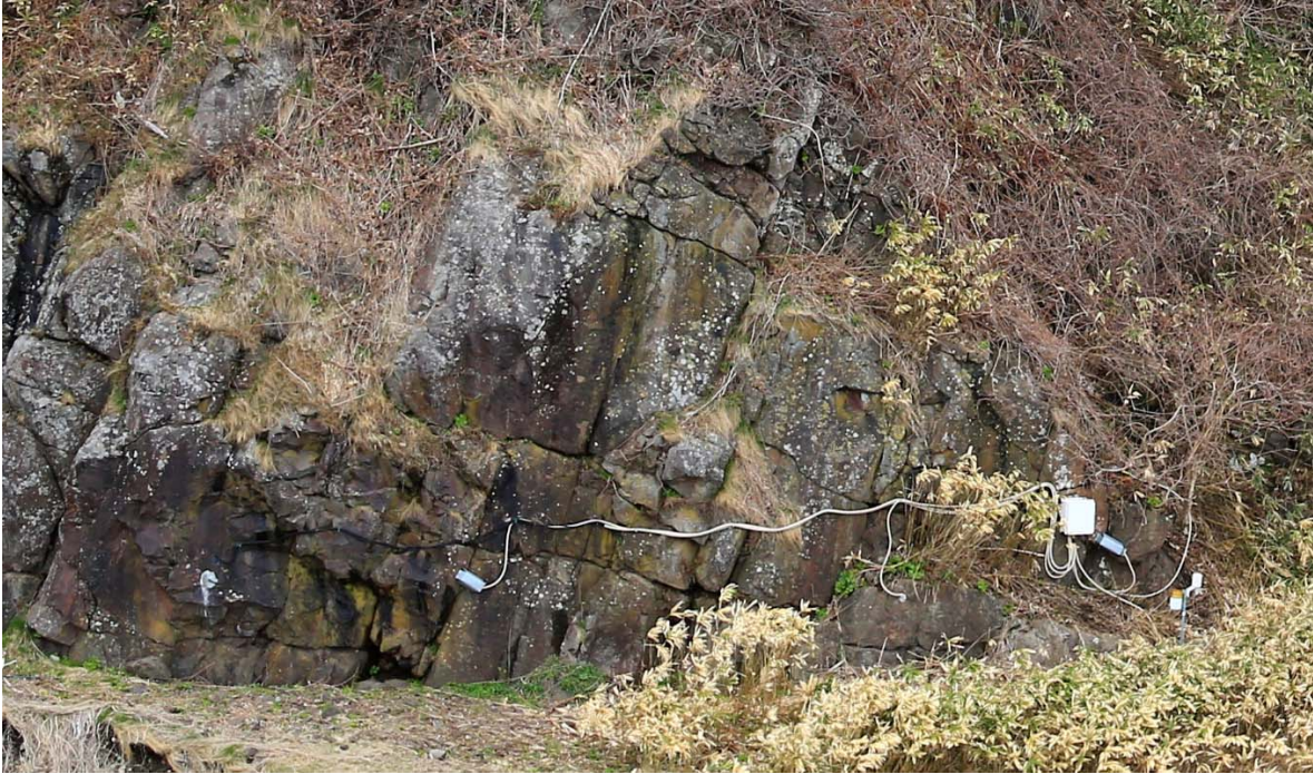
写真 3.13 観測計器設置状況
