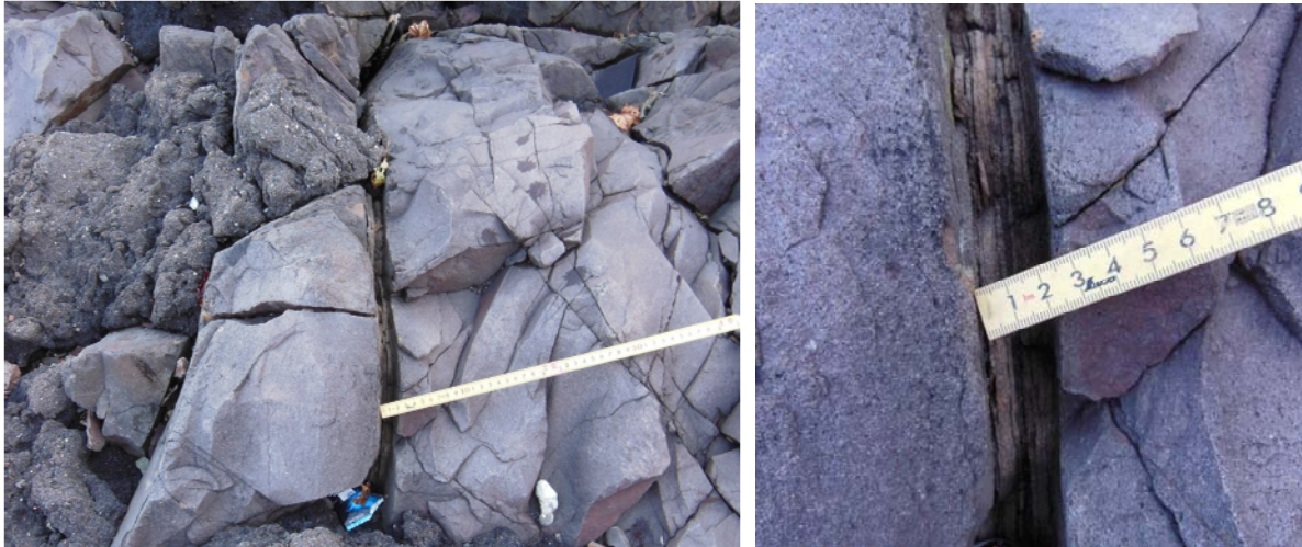
写真 3.16 充填物のある亀裂
