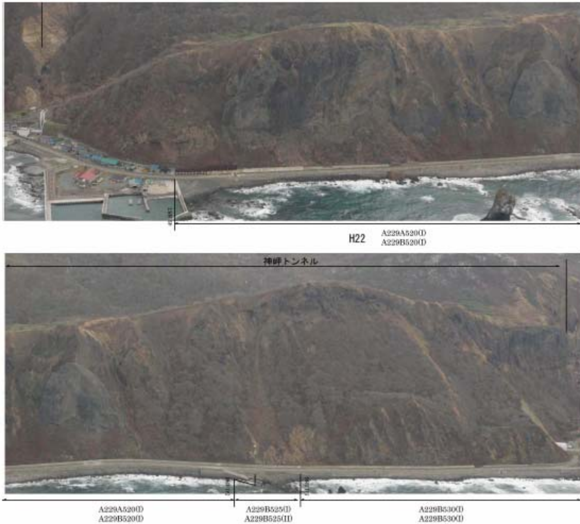
写真 3.6 積丹町神岬地区の空中写真（供用時のもの）
