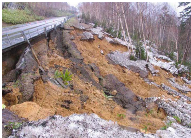
図 8.21 国道 230 号 KP=40.8 土砂災害発生状況 (札幌開発建設部 HP より転載)
