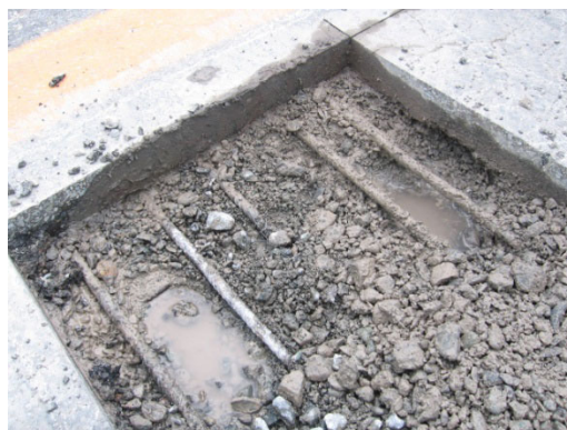
写真 5.2 床版上面の砂利化
