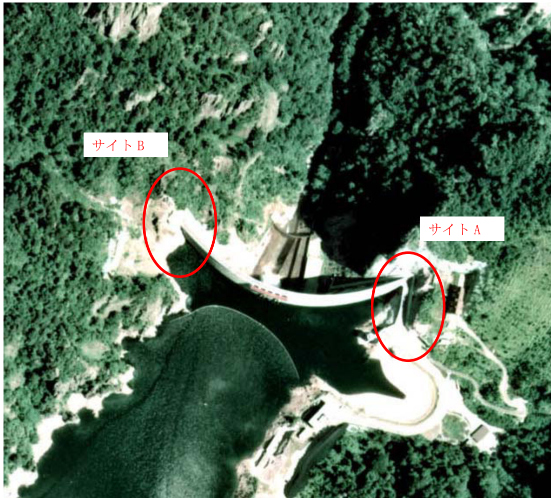
写真 3.8 地上設置型レーザープロファイラーデモ計測箇所図（国土地理院 1977）
