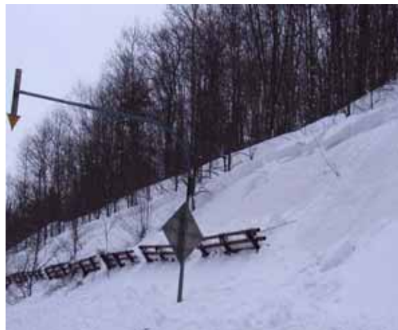
写真 9 - 2 雪崩予防柵をすり抜けた事例
