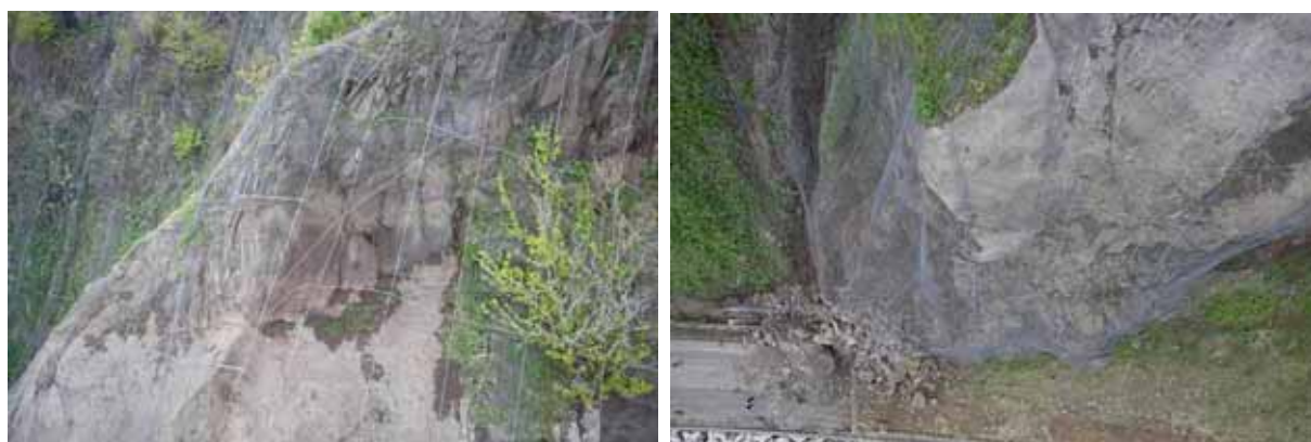
図５－１６ 増毛町岩尾地区におけるラジコンヘリ写真の事例
