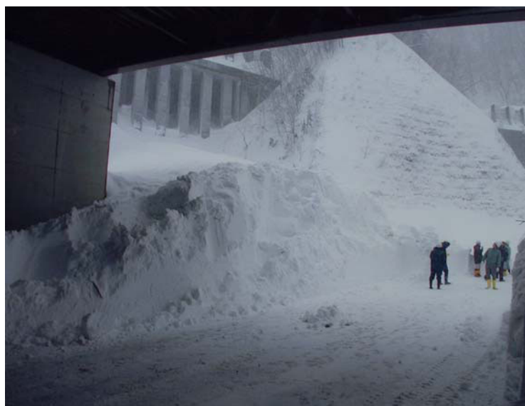
写真12-3 減勢工をオーバーフローした雪崩
