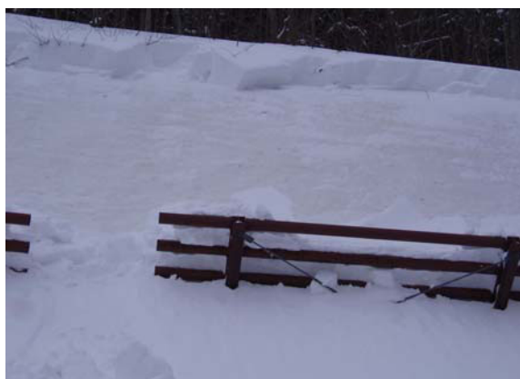
斜面上部に破断面が確認される。すべり面と雪崩予防柵の位置関係から、発生した雪崩は雪崩予防柵をすり抜けて流下し、雪崩末尾の積雪ブロックが予防柵に捕捉されたものと推察できる（事例 No.29）
