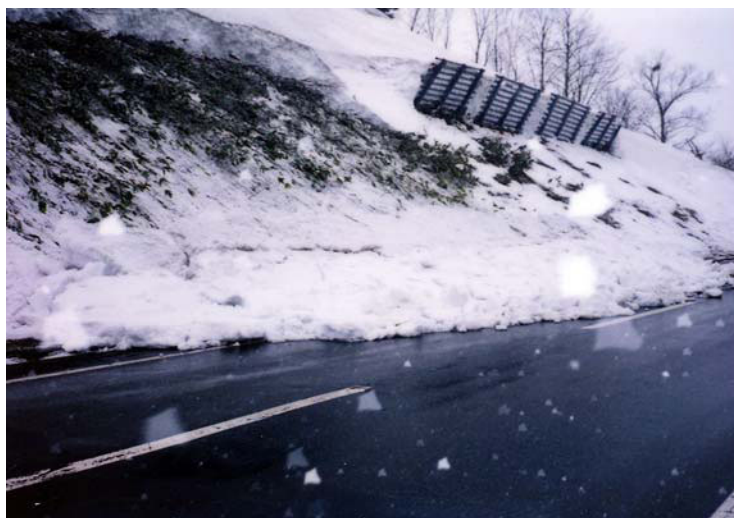
写真12-2 吊柵の下で発生した雪崩から数日後、柵と横並びの位置から発生した雪崩
