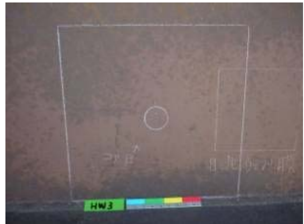
事例8 表面に錆が発生し始めた段階 表面処理剤（安定化処理）が残存している部分と錆が混在
