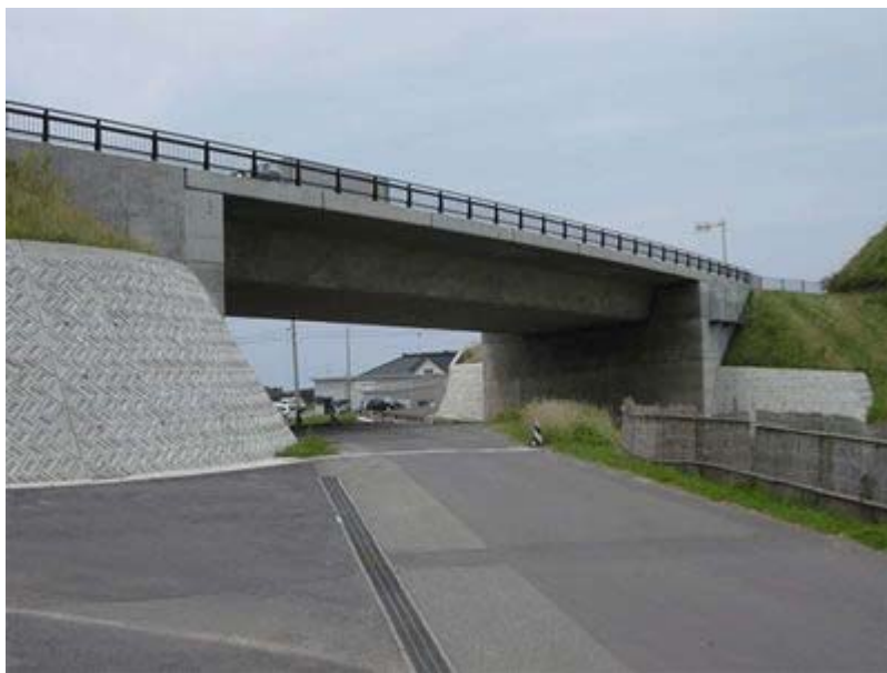
写真 9 - 4 架け替えられた A 橋（東北地整）
