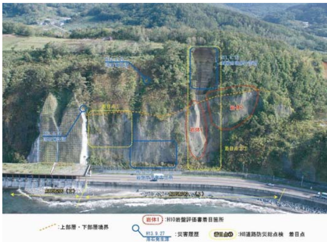
図 7 - 5 忍路地区の過去の点検における着目点
