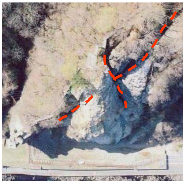
図7-39 岩体背後の交差する亀裂
