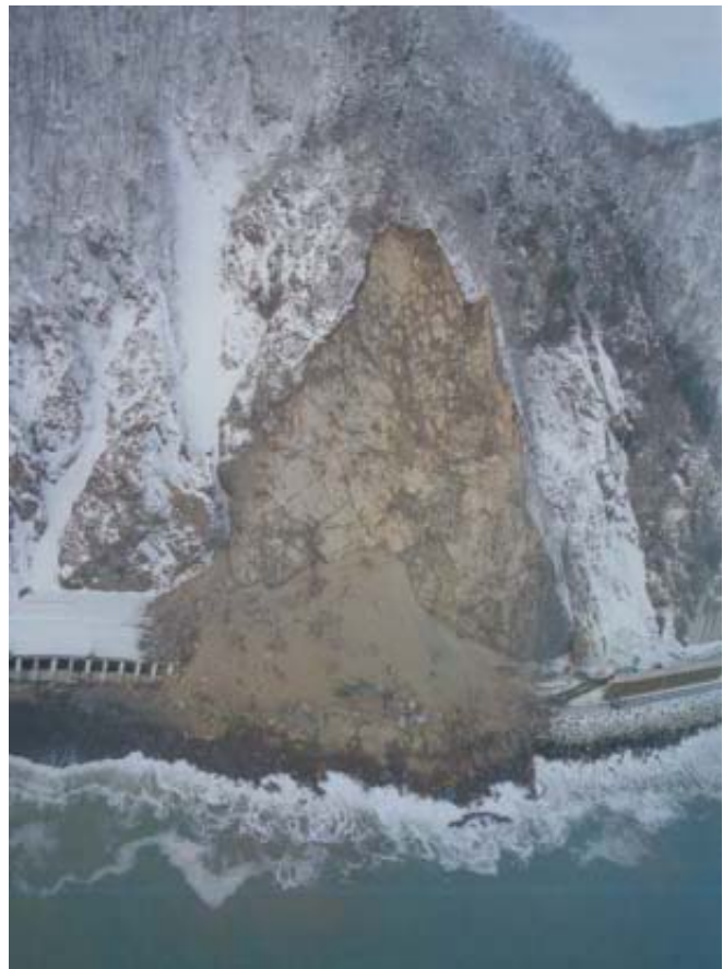
図7-28 崩壊箇所全景
