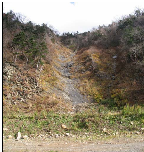
図6-3 計測箇所 (国道230号 KP37.0 定山溪トンネル起点坑口付近)
