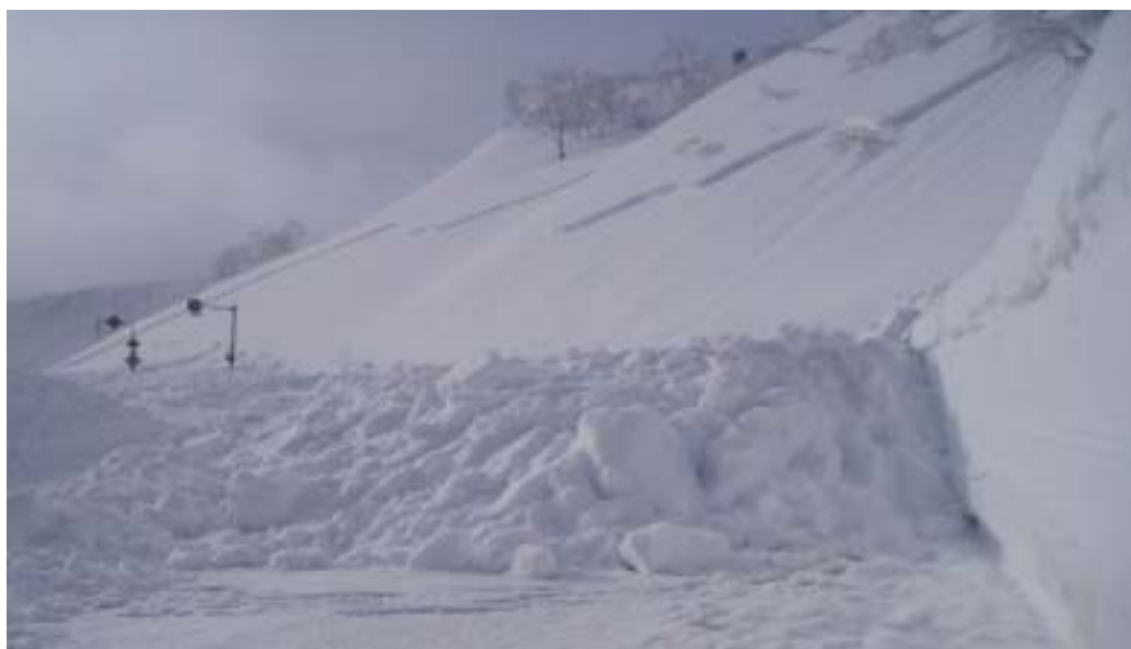
写真 1 2 - 1 面発生新雪（乾雪）表層雪崩（一般国道 243 号美幌峠）
