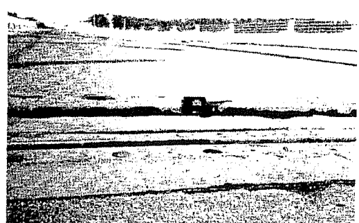
写真四 橋台裏込部の凍上
