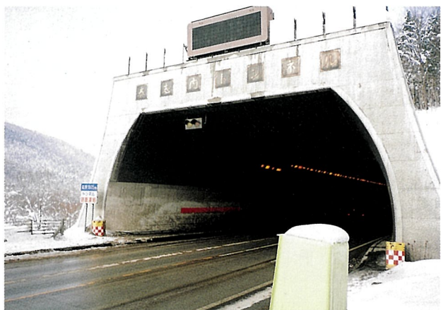
春志内トンネル 札幌側坑口
