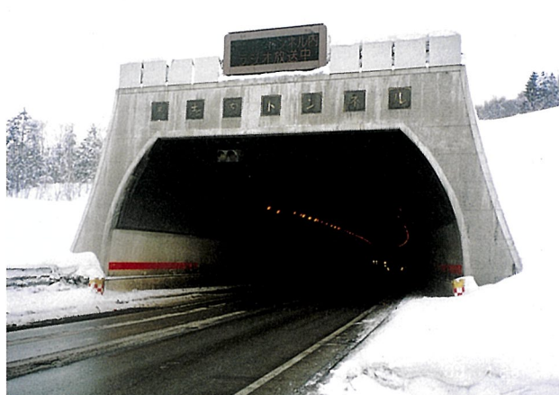
春志内トンネル 旭川側坑口
