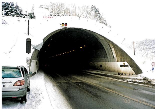
神居古潭トンネル 旭川側坑口
