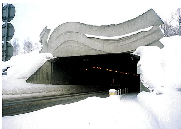
旭川トンネル 旭川側坑口
